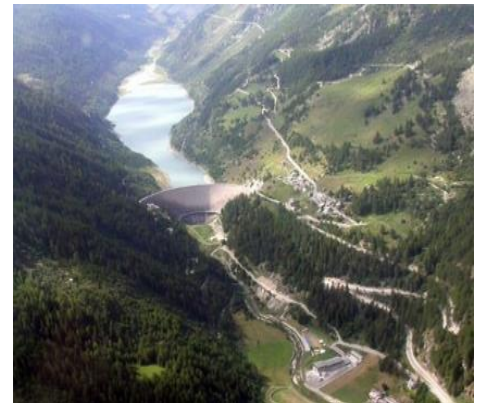
Vista aerea sulla diga
